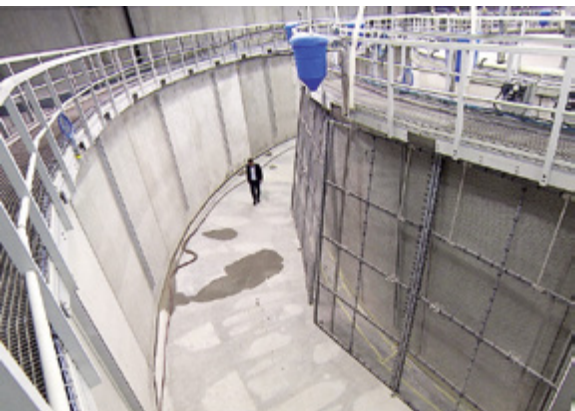
Das Salzwasserbecken: Durchmesser 32 Meter, Tiefe sechs Meter. Hier wachsen die Junglachse ein Jahr lang heran.
